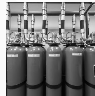
IMPIANTI DI SPEGNIMENTO A GAS INERTE
