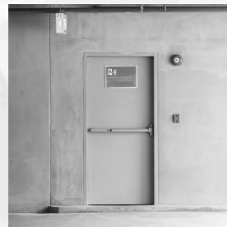
PORTE TAGLIAFUOCO E USCITE DI EMERGENZA
